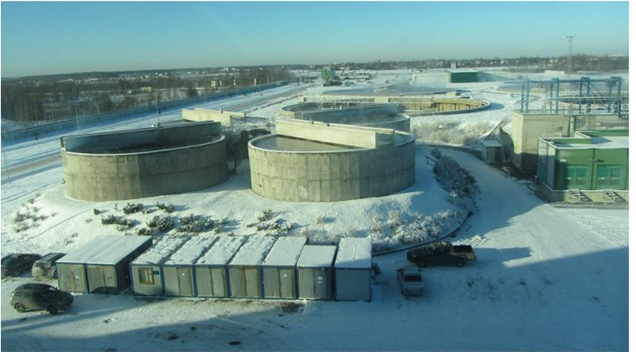
Фото 6. Вид на ЮЗОС: на переднем плане вторичные отстойники.
