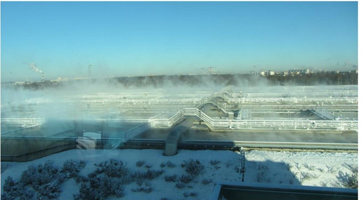
Фото 5. ЮЗОС: вид на коридоры чередующихся аэротанков: аэрируемые, сероводородные.
